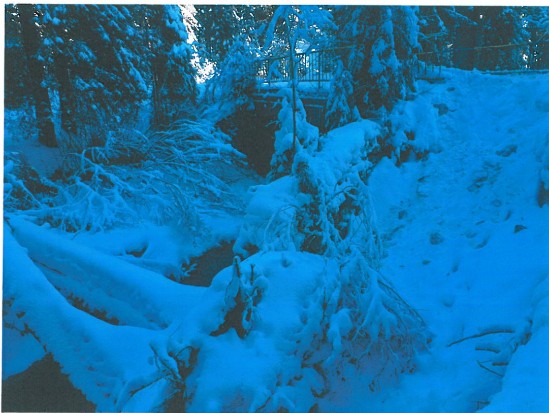
Foto 10: Imagine asupra albiei amonte pod.
