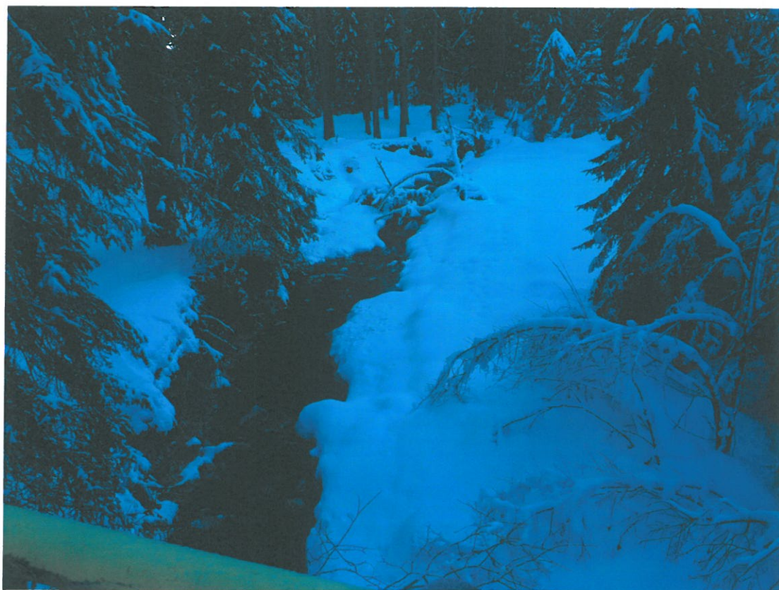
Foto 11: Imagine asupra albiei aval pod.
