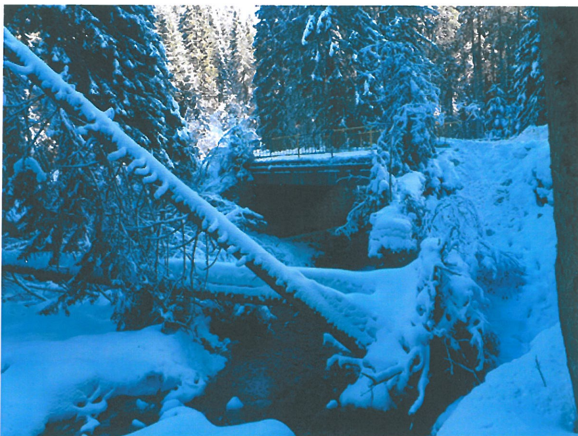
Foto 1: Elevatie amonte pod existent.
