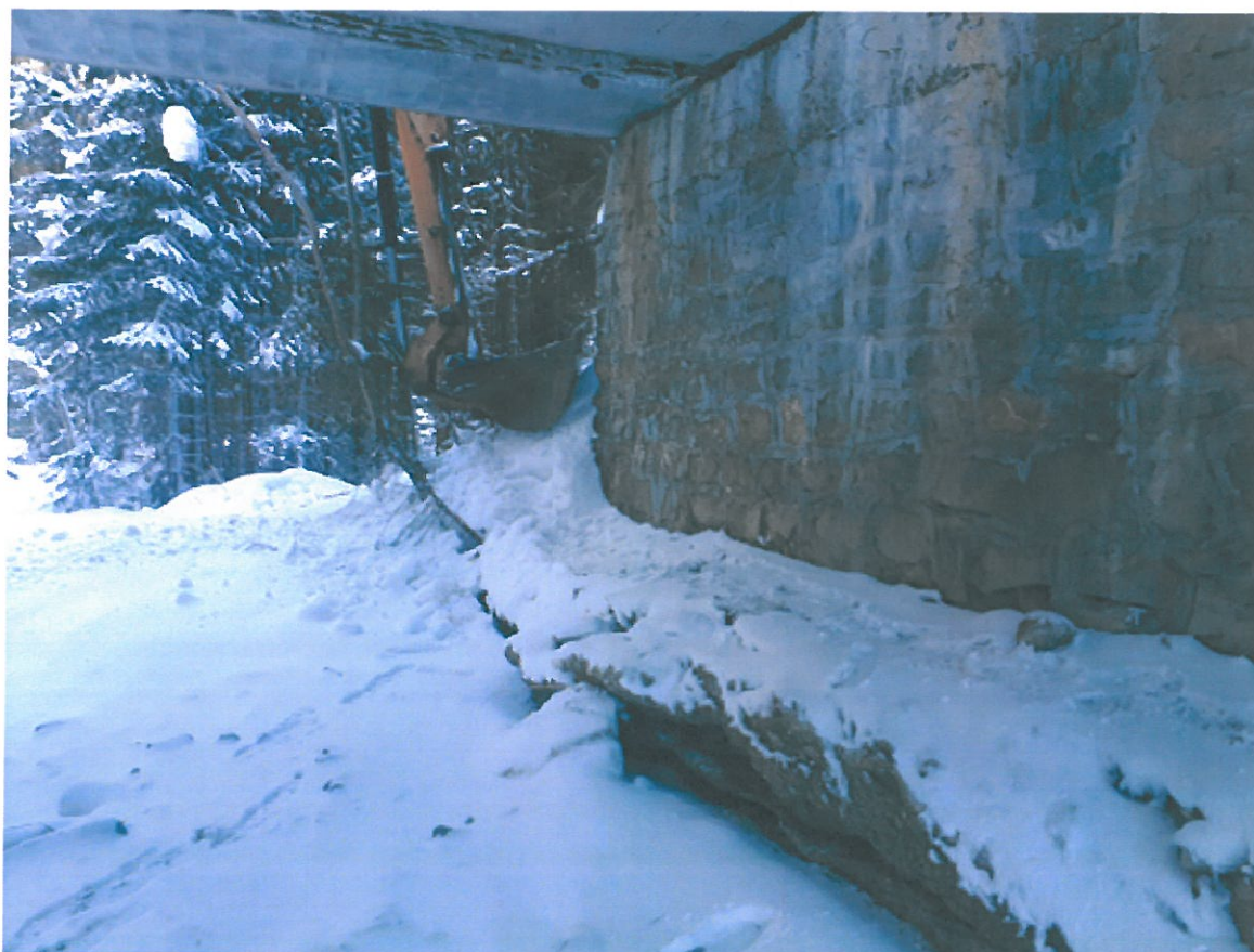
Foto 3: Vedere fundatie si elevatie culee.
