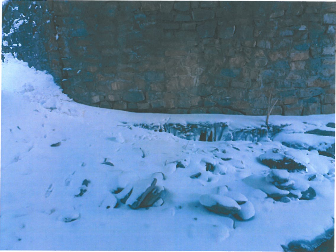
Foto 5: Imagine de ansamblu culee, zidarie de piatra.
