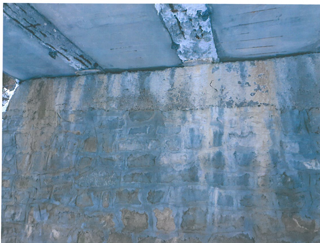
Foto 8: Imagine de detaliu culee si grinzi ce reazema direct pe bancheta de beton armat.
